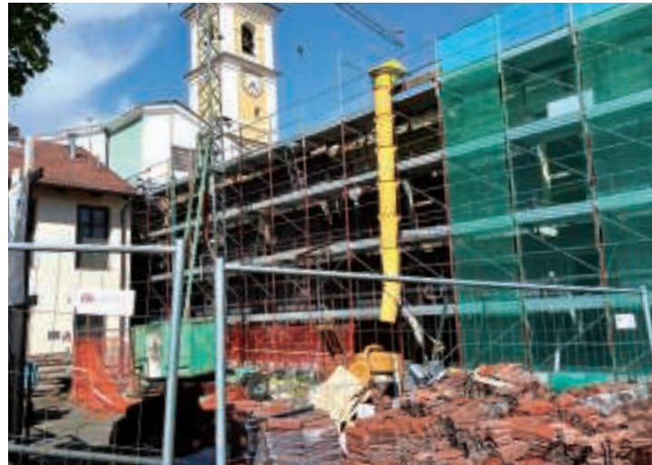
I ponteggi nel cortile dell'ex Cottolengo
